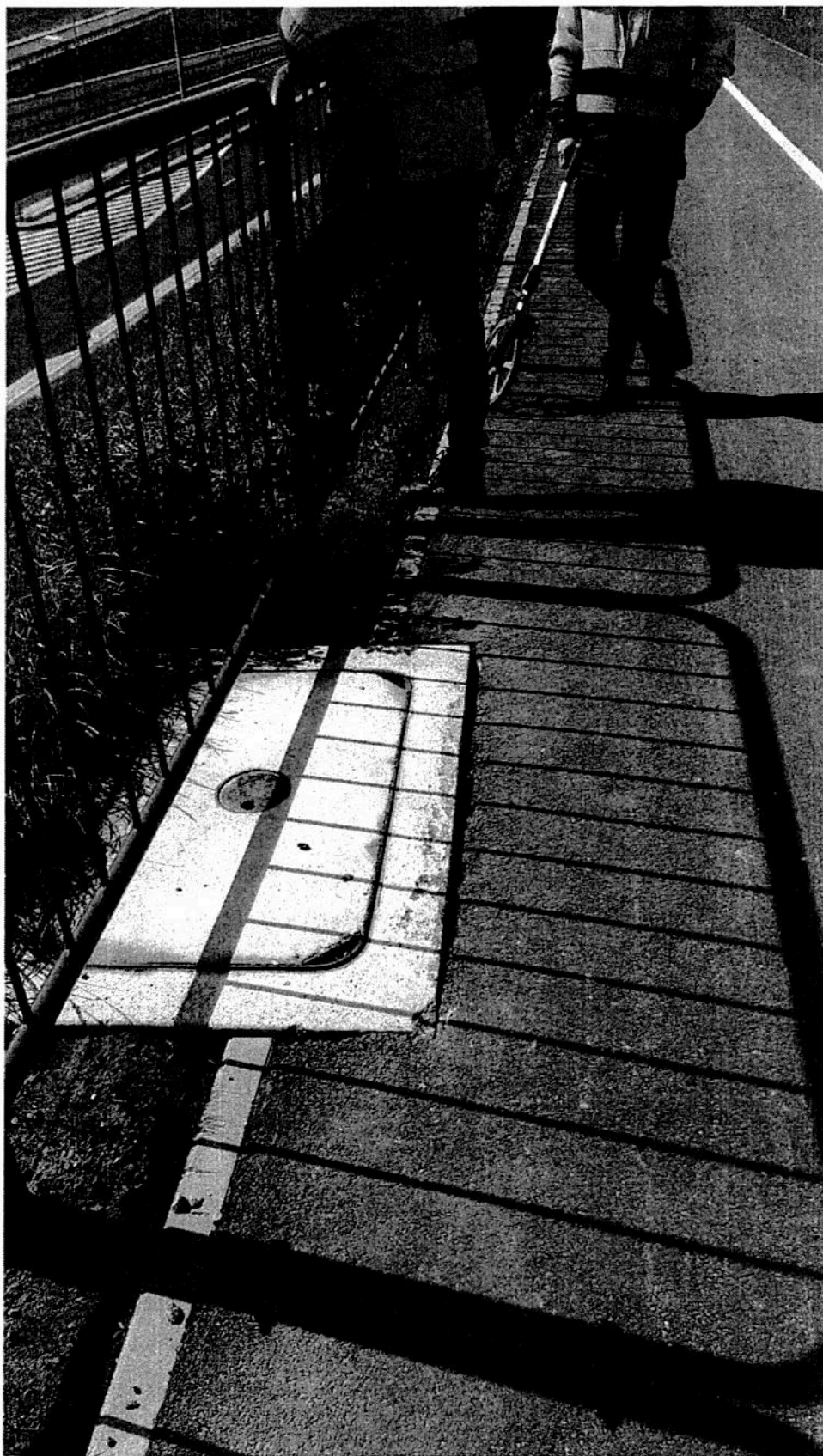
5) Jezdnia wschodnia – 200 m od ul. Lubelskiej – uzupełnić masą na zimno i zasmarować bitumem
