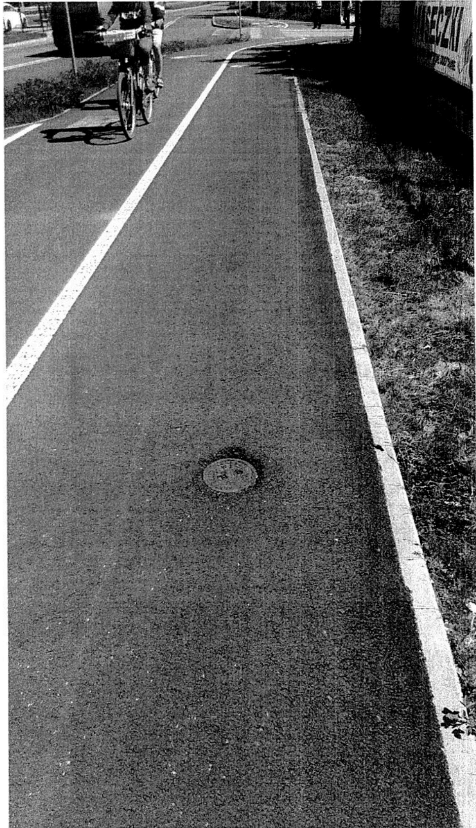
10) Jezdnia zachodnia – skrzyżowanie ul. Ogrodnicza – obrobić zawór i zalać bitumem
