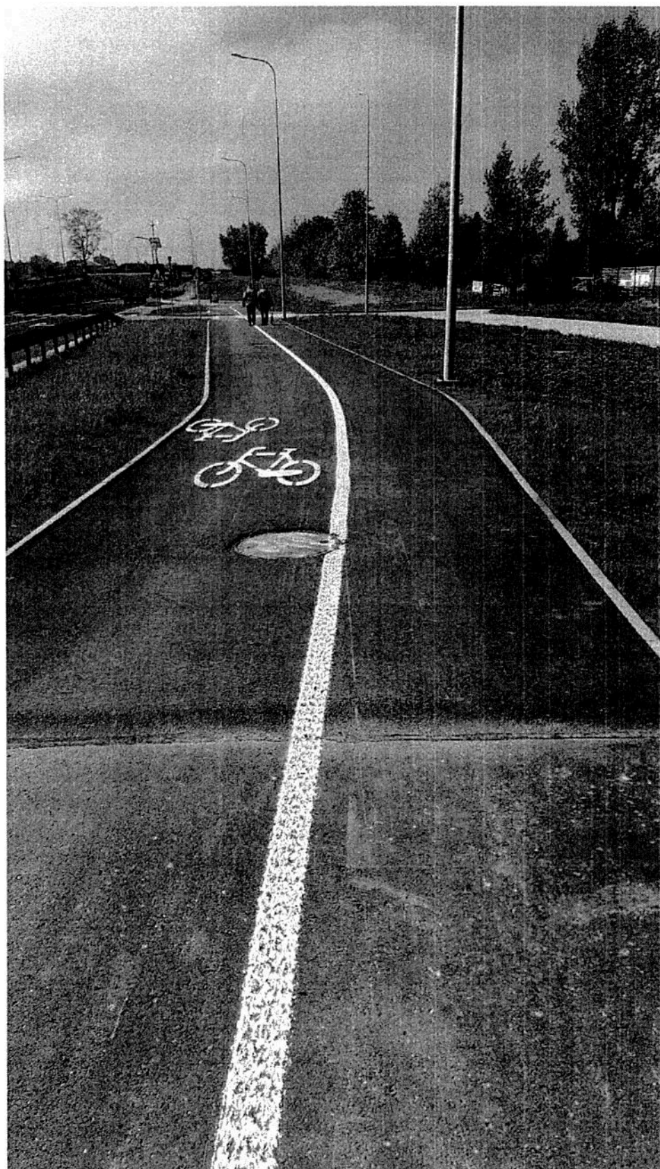
2) Jezdnia wschodnia – ALGA – nawierzchnia do wymiany od złącza do przejścia dla pieszych przy przystanku autobusowym – 54 \times 3,5 = 189 \text{ m}^2
