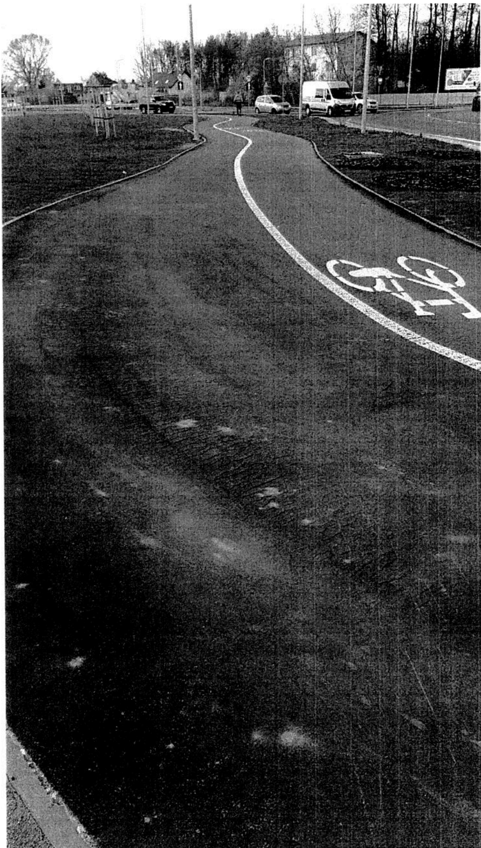
12) Zwolińskiego – Wojska Polskiego – ścieżka wzdłuż stacji ORLEN – wymiana nawierzchni - 80x3,5=280 m 2
