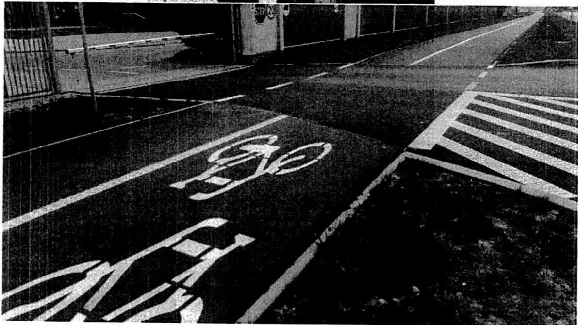
5) Jezdnia północna – ścieżka pomiędzy czwartym i piątym zjazdem od wiaduktu do ronda Ks. J. Popietuszki – wymiana nawierzchni od zjazdu do zjazdu - 14,5 \times 3,5 = 50,75 \text{ m}^2
