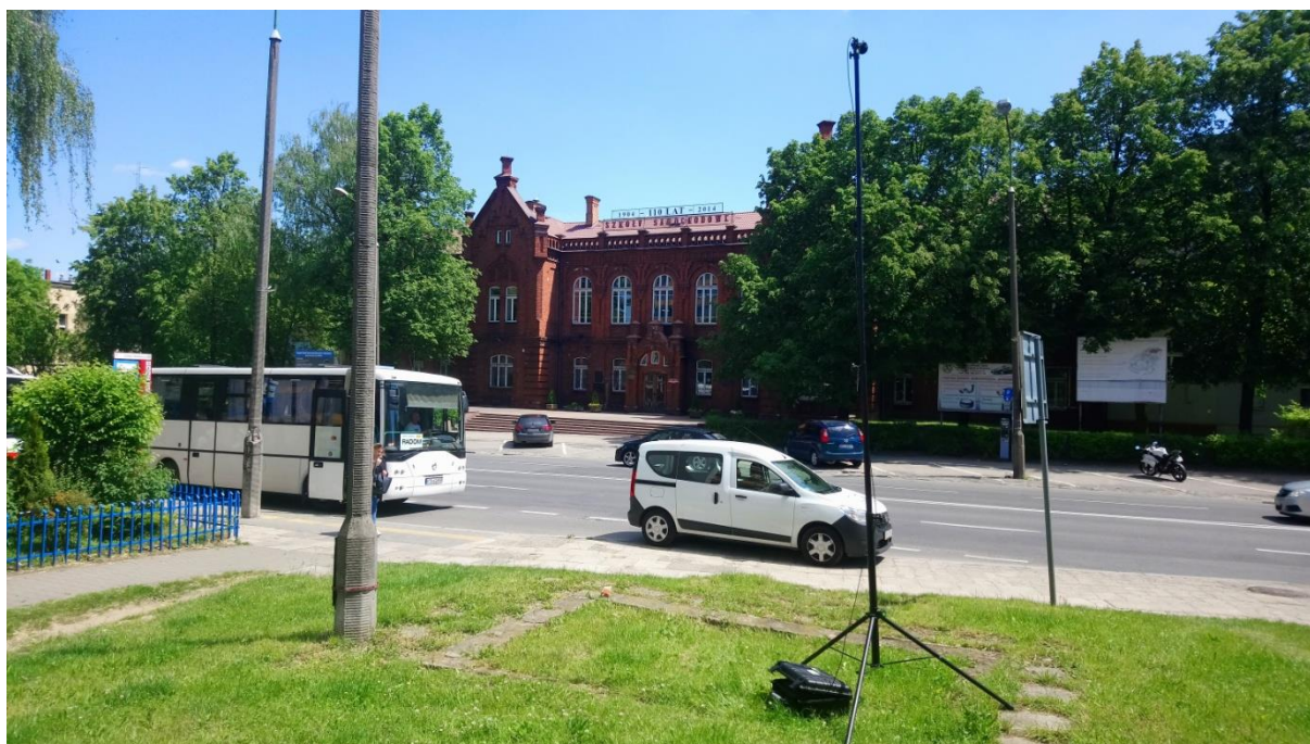
Przykładowa zabudowa na terenach zabudowy związanej ze stałym lub czasowym pobytem dzieci i młodzieży - ul. 25 czerwca
