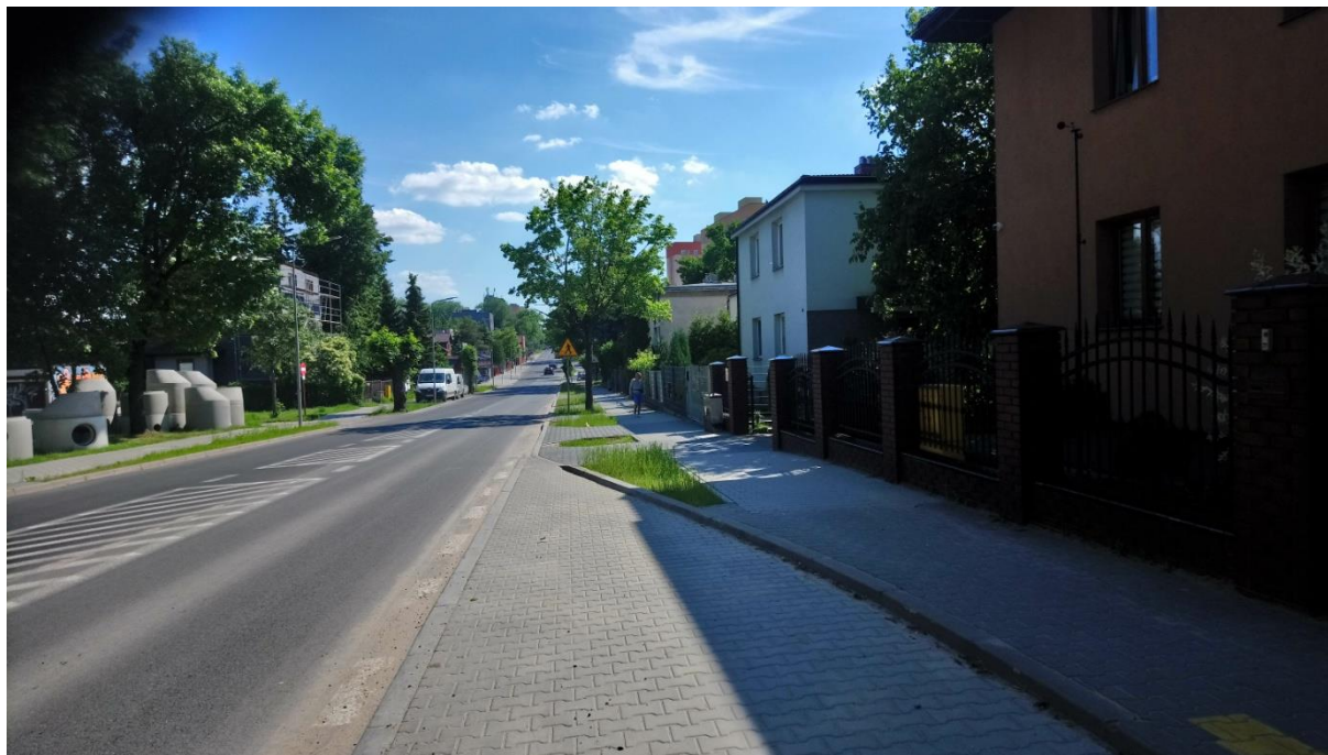
Przykładowa zabudowa na terenach zabudowy mieszkaniowej jednorodzinnej – ul. Stanisława Zbrowskiego
