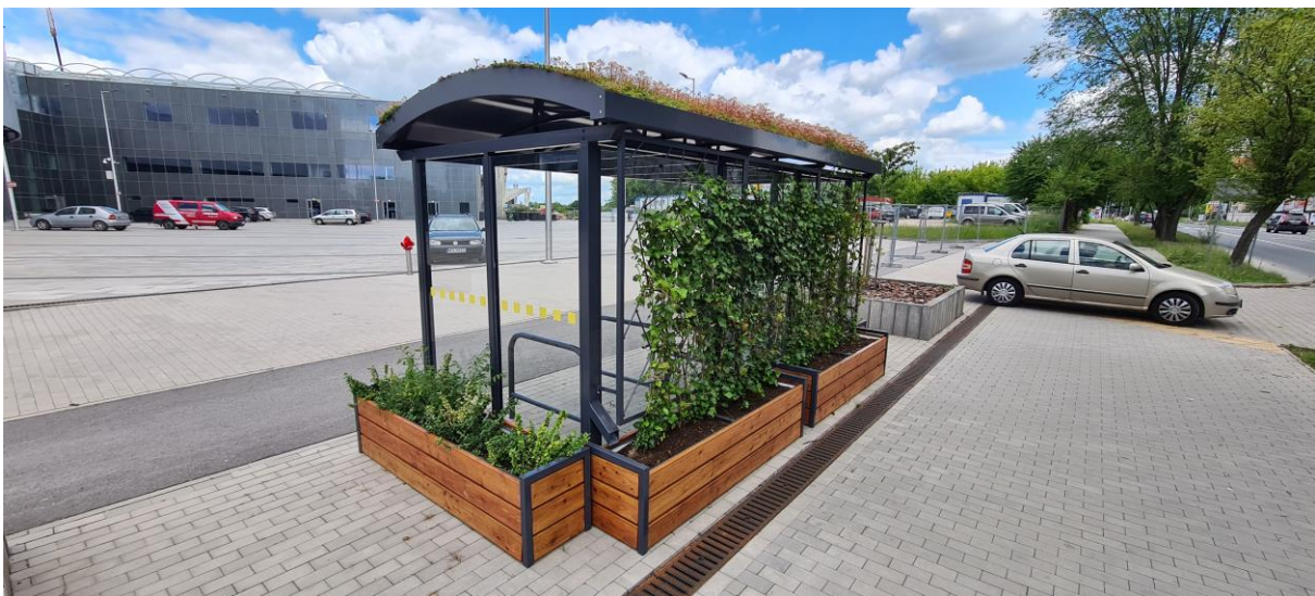
Fot.20. Zastosowanie „zielonego dachu” z wykorzystaniem przystanku autobusowego przy ul. Struga (materiały własne UM)
